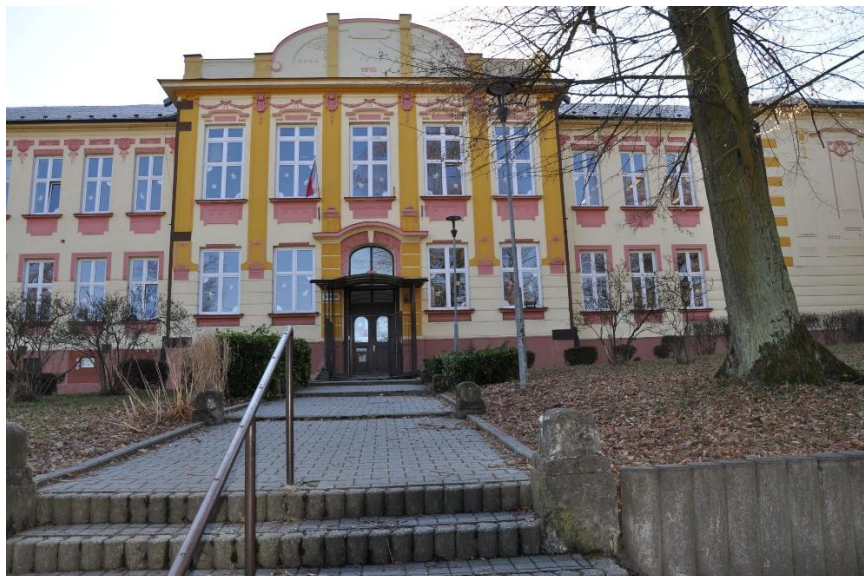
Obrázek 11 Budova základní školy 20
